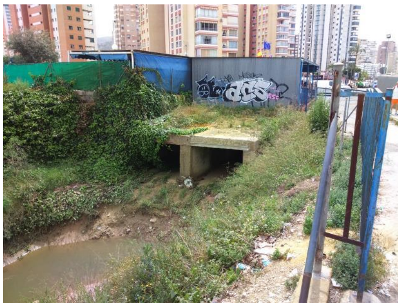
Obra de captación existente en el barranco antes del cruce con Bernat de Sarriá
