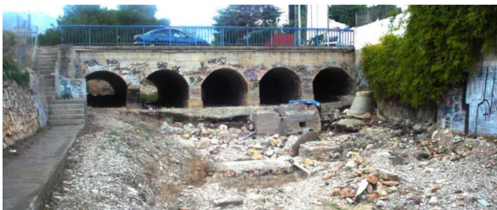
Vista obra de paso sobre el barranco
